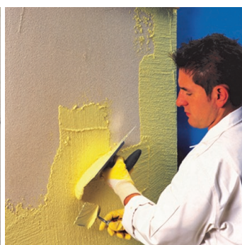
Obr.3 Nanesení omítky nerezovým hladítkem.
