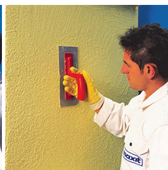
Obr.4 Strukturování povrchu plastovým hladítkem.
