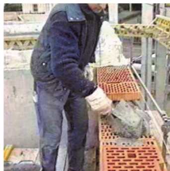
Obr.2 Nanášení zdicí malty na zdivo.
