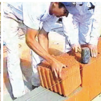
Obr.3 Pokládání cihelných bloků.
