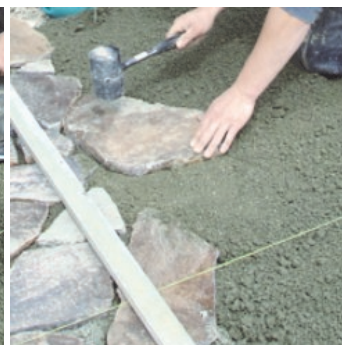
Obr.3 Usazení kamene gumovou palicí.
