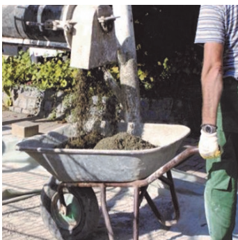
Obr.1a Namíchání kontinuální míchačkou.
