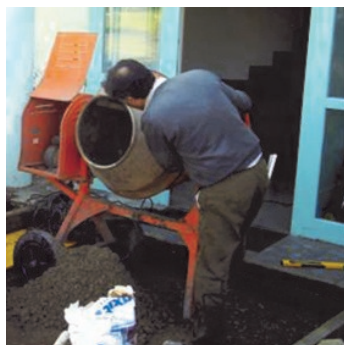
Obr.1b Namíchání bubnovou míchačkou.
