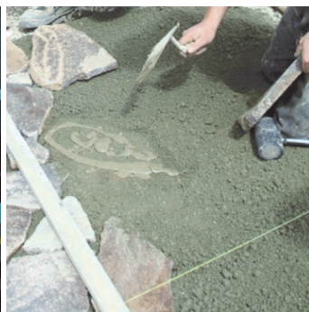
Obr.2 Urovnání betonového lože, osazení kamene a nanášení lepidla na plochu pod kámen a na kámen.
