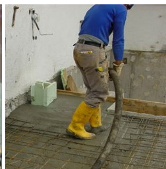
Obr.4 Vylévání betonu do připraveného bednění.
