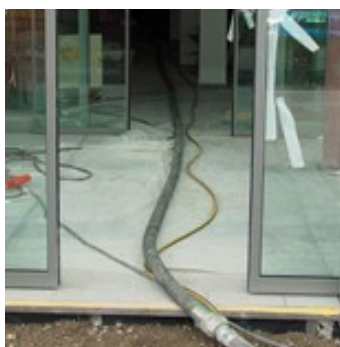
Obr.3 Doprava materiálu hadicí přesně namísto určení.
