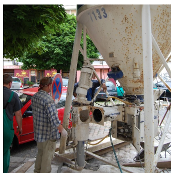
Obr.2 Namíchání a čerpání materiálu pomocí m-tec SMP.
