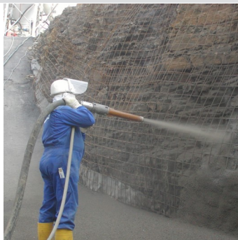
Obr.3 Násřik betonu na podklad.
