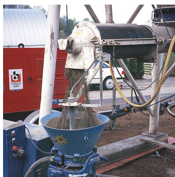
Obr.2 Dávkování suché směsi do podávacího stroje pomocí kontinuální míchačky namontované pod.
