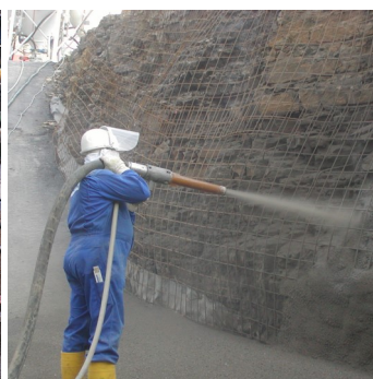
Obr.3 Nástřik betonu na podklad.
