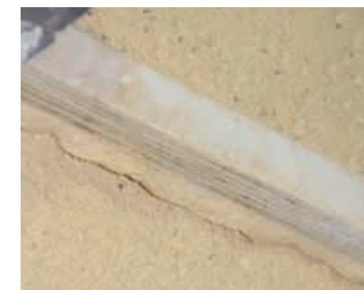
Putz mit einer Putz- oder Holzlatte aufziehen.
