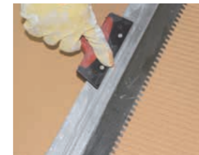
Struktur mit einem Putzkamm erstellen.
