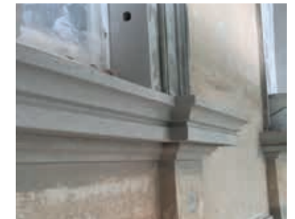
Glattere Strukturen werden durch den Auftrag von maxit ip Feinzug erreicht.
