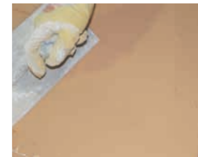
Auftrag der Putzschicht in gewünschter Putzdicke.
