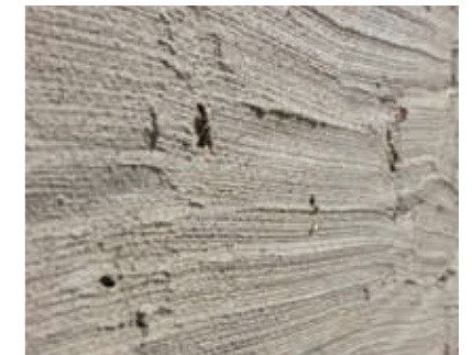
Auftrag von maxit eco 70 als Haftbrücke auf den tragfähigen Bestandsputz.
