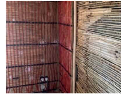
Für die Befestigung der Wandheizungen werden bei Lehmputzen oft Schilfrohmatten eingesetzt.
