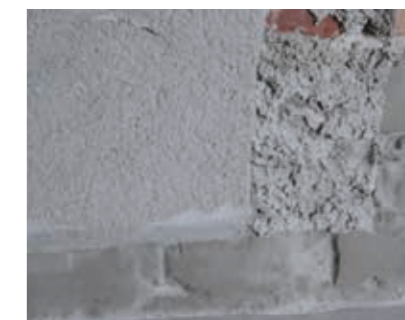
Anbindung der Abdichtung im Fußpunkt des Kellers.
