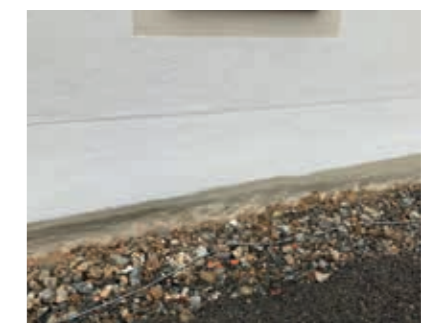
Sockel, mit maxit san Vario und Putzabdichtung fertiggestellt.
