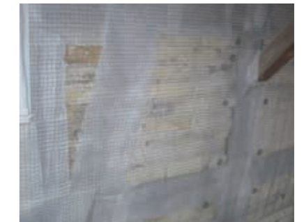
Befestigung diffusionsoffener Trennlage (Trennvlies) auf Holz. Befestigung des Putzträgers Welnet im Gefach.
