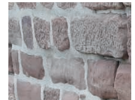
Deckfugenmörtel maxit mur 950 HS. Aufrauen der Oberfläche mit einem Holzbrett oder einer Stahlklinge möglich. Bei nicht saugendem Mauerwerk hydrophobierten Deckfugenmörtel einsetzen.
