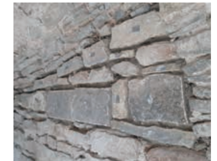
Gereinigtes Natursteinmauerwerk. Entfernen der nicht tragfähigen Fugenmörtel, standardmäßig 2 cm tief.
