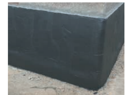
Auftrag der bituminösen Dickbeschichtung (PMBC) maxit san Superdicht 2K.
