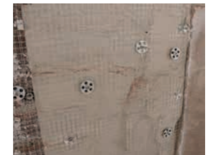
Anbringen eines Putzträgers (Distanet o. Ä.) im freigelegten Bereich unter Verwendung der erforderlichen Befestigungsmittel.
