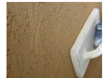
Filzen der Oberfläche.
