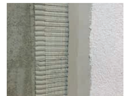
Aufbringen der Armierungslage und eines mineralischen Oberputzes.
