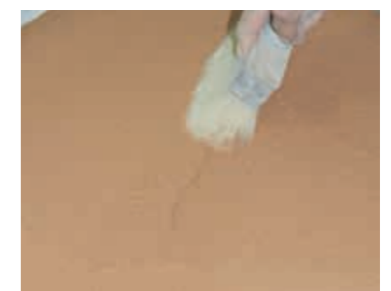
Für eine Verstärkung der Struktur angezo-genes Material mit Malerbürste bearbeiten.
