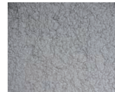
Oberfläche nach Fertigstellung.
