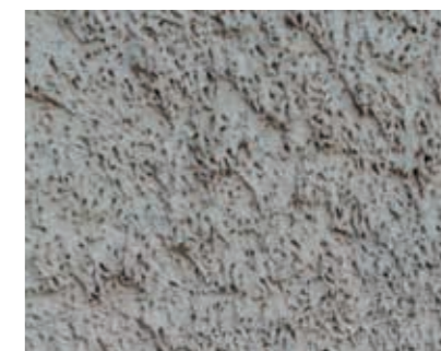
Fertige Struktur nach der Bearbeitung.
