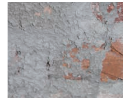
Nicht deckender Spritzbewurf mit maxit san Vorspritz.
