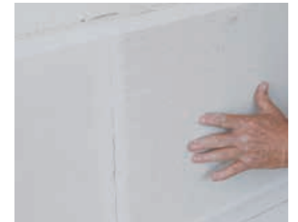
Für eine vollflächige Verklebung Platte 2 – 3 cm verschieben. Einsatz des Buttering-Floating-Verfahrens (mit zusätzlichem Kleberauftrag auf den Untergrund) bei größeren Unebenheiten.
