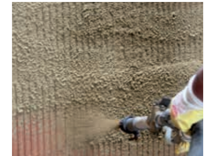
Putzauftrag mit Hand oder mit einer handelsüblichen Putzmaschine.
