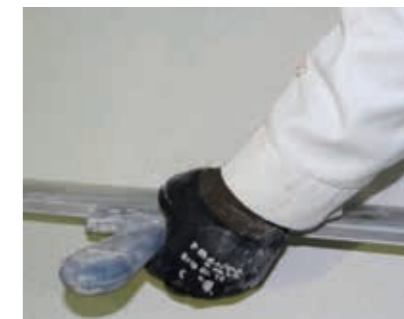
Einebnen des Untergrundes. Verschleichen der Fläche.
