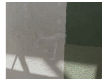
Bei sandenden Altputzen Grundierung mit maxit prim 1070 . Füllen größerer Risse mit Voranstrich.
