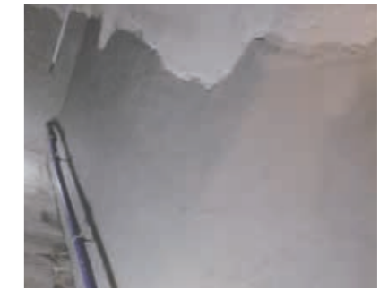
Abdichtung mit maxit AD-1K-Außendicht in zwei Lagen (Trockenschichtdicke 2 mm).
