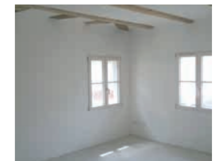
Fertige Fläche nach Auftrag der zweiten Lage Lehmputz und Anstrich.
