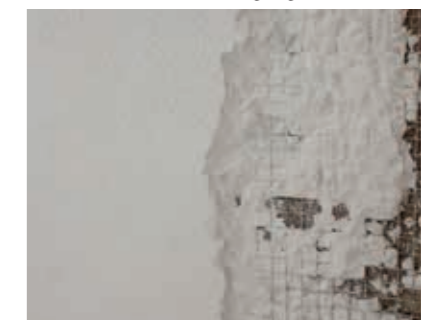
Putzauftrag bis zum Bestandsputz. Weitere Vorgehensweise: siehe 3.2
