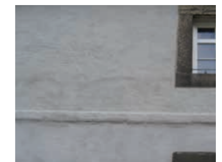
Auftrag eines Oberputzes. Ein freskaler Anstrich ist in den noch frischen Oberputz aufzubringen.
