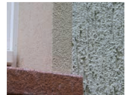
Fertiggestellte Fläche mit Armierungspachtelung aus maxit eco 73 und maxit Armierungsgewebe und einem Oberputz maxit Schleppputz Klassik.
