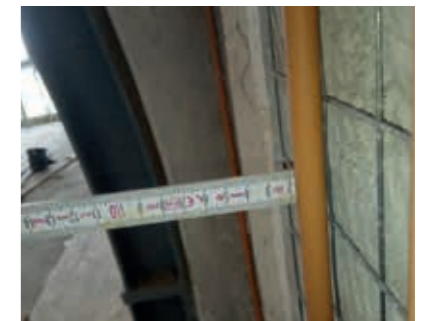
Anbringen des Putzträgers, Verdübelung im Putzgrund. Befestigung der Wandheizung am Putzträger.
