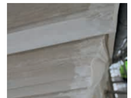
Beistucken der Stöße und Vergleichmäßigen der Oberflächen.
