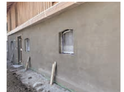
Auftrag einer weiteren Sanierputzlage mit maxit san Standard.
