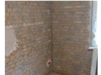
Untergrundvorbehandlung mit einem nicht deckenden Vorspritz zur Vergleichmäßigung des Saugverhaltens.
