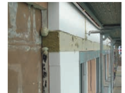
Aufdopplung der Dämmplatte mit nachträglichem Einbau des Brandriegels.
