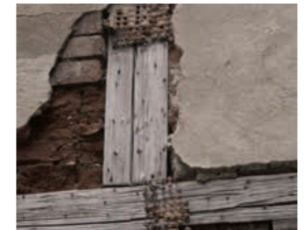
Überputztes Fachwerk im Bestand. Entkopplung der Fachwerkhölzer mit Ziegelrabitz.
