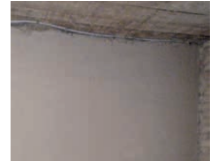
Putzauftrag maxit ip 383/maxit ip 382 purcalc NHL in einer Auftragsdicke von 10 – 15 mm.
