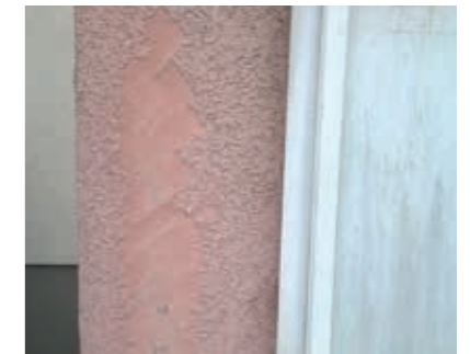
Prüfen des Untergrundes.
