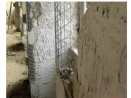
Auftrag der Innendämmung maxit eco 71.
