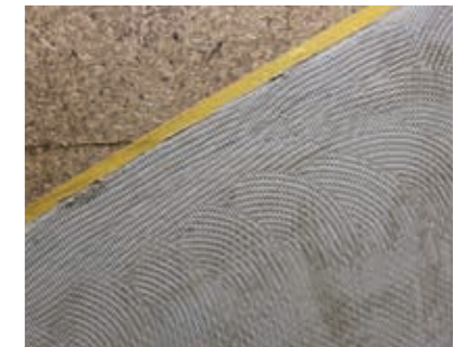
Auftrag einer weiteren Putzschicht aus maxit ip 315 purcalc mit Einlage von maxit Armierungsgewebe PS.
