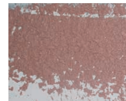
Anwerfen des Materials mit Dreieckskelle.
