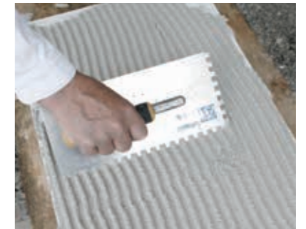
Vollflächiger Auftrag von maxit multi 307 mittels Zahntraufel (10 mm) auf die Dämmplattenrückseite.
