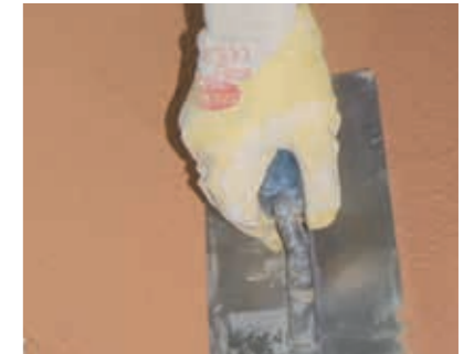
Auftrag der Putzschicht in gewünschter Putzdicke.
