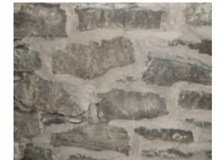
Verfugung mit maxit mur 950 HS. Bei tieferen Fugen sollte eine Grundverfugung mit einer Deckverfugung ausgeführt werden.
