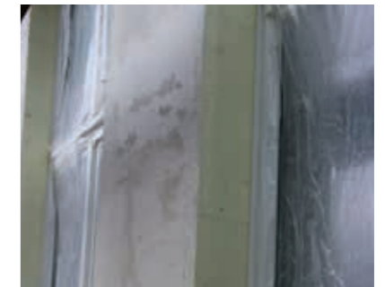
Auftrag von maxit eco 72 in der gewünschten Auftragsdicke.
