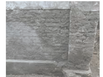
Freigelegtes, mit maxit san Vorspritz vorbehandeltes Mauerwerk.
