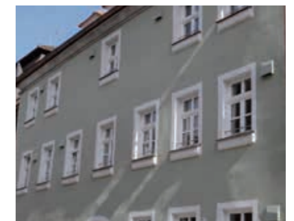
Putzauftrag mit Unterputz/Dämmputz. Zur Rissminimierung Gewebespackelung vor dem Oberputzauftrag.
