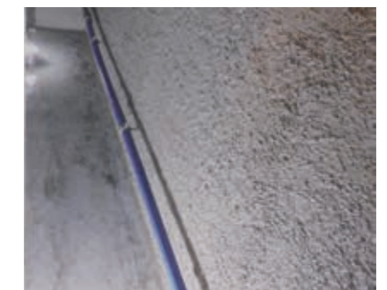
Einwurf des maxit san Vorspritz in die frische Dichtungsschlämme.
