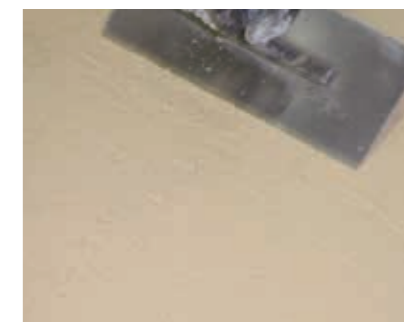
Auftrag der Putzschicht in gewünschter Putzdicke.
