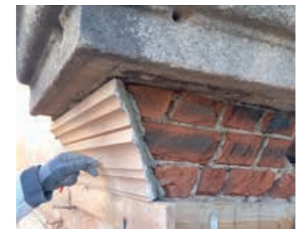
Stuckteile werden vor Ort an die Fassade geklebt und mit Dübeln im Mauerwerk befestigt.
