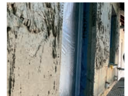
Auftrag von maxit ip 78 therm Grundputz in einer Gesamtdicke von ca. 15 mm.
