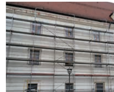
Einsatz eines Sanierputzsystems nach WTA-Richtlinien bis 0,8 m über der erkennbaren Schadensgrenze.
