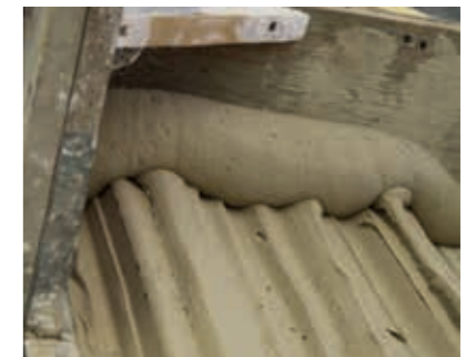
Auftrag von maxit ip Feinzug auf angesteiften Grobzug – für eine feinere, geschlossenerere Struktur.
