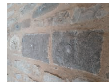
Fugenoberfläche, aufgeraut mit einem Holzbrett oder einer Stahlklinge.
