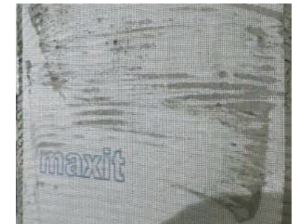
Nach dem Funktionsheizen Auftrag einer Armierungsspachtelung mit maxit ip 315 purcalc.
