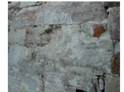
Freigelegtes Mischmauerwerk.
