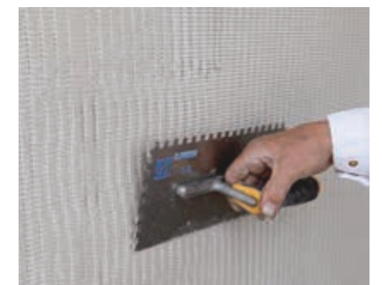
Auftrag einer Gewebespachtelung aus maxit multi 307 und Armierungsgewebe MW.
