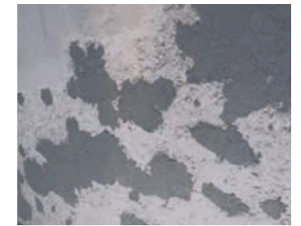
Altputz entfernt, Untergrund gereinigt. Ausgleich von Unebenheiten durch Ausgleichsschicht mit maxit san Stop, Putzdicke ≤ 20 mm.
