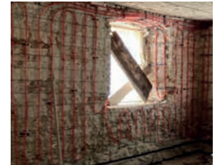
Anbringen der Wandheizung auf den vorbereiteten Untergrund.
