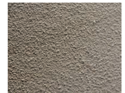
Fertig gefilzte Oberfläche.
