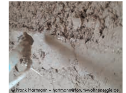
Aufbringen der Wärmeverteilschicht.
