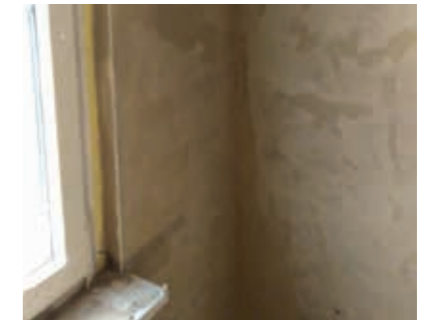
Bei hohen Auftragsstärken ist mehrlagig zu arbeiten. Oberfläche aufrauen, Standzeiten einhalten.
