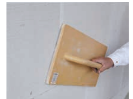
Egalisieren von Unebenheiten mit einem Schleifbrett.
