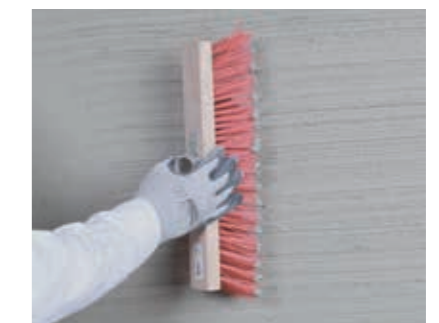
Aufräumen der Oberfläche und Einhalten der Standzeit (1 Woche pro cm Putzdicke).
