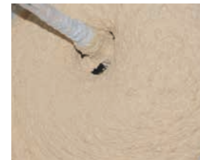
Verarbeitung des Materials mit einem Quirl oder einer gängigen Putzmaschine.
