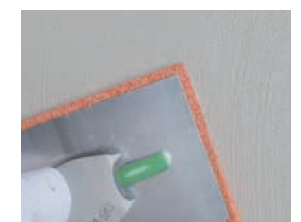
Auftrag einer Armierungspachtelung aus maxit ip 315 purcalc und maxit Armierungsgewebe PS, Oberfläche filzen.
