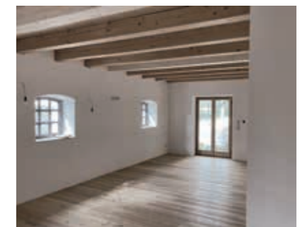
Putztechnische Instandsetzung der Innenbereiche mit einem Sanierputz.
