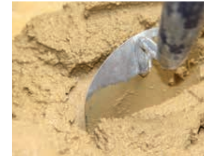
Anmischen des Lehmputzes zu verarbeitungsfähiger Konsistenz.
