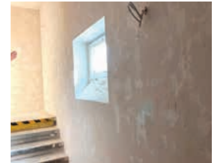
Auftrag der Putzlage mit maxit ip 380/ maxit ip 382/ maxit ip 383, Oberfläche aufgekämmt. Nach Standzeit weitere Putzlage mit einer Überdeckung von 10 mm.
