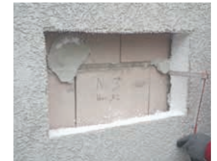
Überprüfung der Tragfähigkeit des vorhandenen WDV-Systems.
