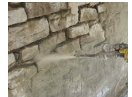
Trockenspritzverfahren ermöglicht optimale Flankenhaftung und Tiefenverfugung.
