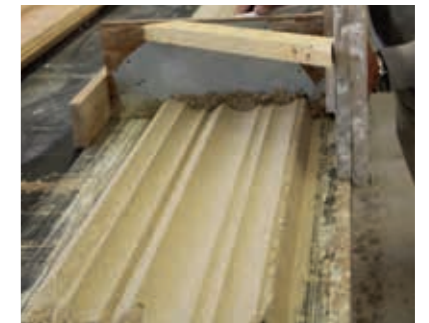
Aufbau von maxit ip Grobzug bis der Schlitten die Form gut abbildet.
