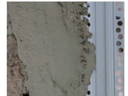
Anbringen systembezogener Leisten als Eck-, Sockel- und Abzugsleisten mit maxit eco 70.
