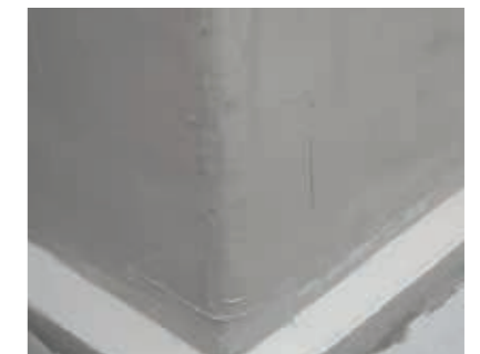
Auftrag der Abdichtung (MDS), zweifacher Auftrag mit einer Mindesttrockenschichtdicke von 2 – 3 mm.
