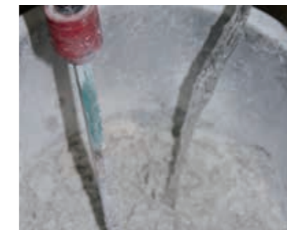
Anrühren des Materials. Zugabe von Wasser bis Verarbeitungskonsistenz erreicht ist.
