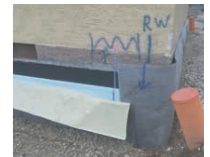
Schutz der Abdichtung mit Drainagematte und Ausführung einer Perimeterdämmung.
