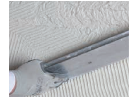
Auftragen und Verziehen von maxit ip 76 therm.
