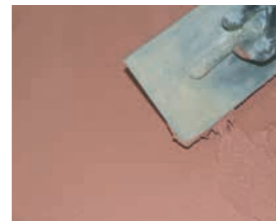
Auftrag des Rillenputzes in Kornstärke mit einer Edelstahltraufel.
