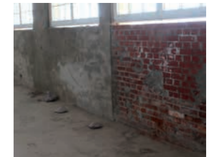
Auftrag von maxit Kompressenputz oder Porengrundputz maxit san Grund in einer Auftragsdicke von 20 mm, Oberfläche aufgeraut. Verstärktes Anlösen der Salze durch Befeuchten der Oberfläche.
