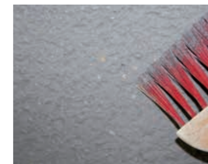
Oberfläche des Kratzputzes durch Abkehren von der freigelegten Körnung befreien.
