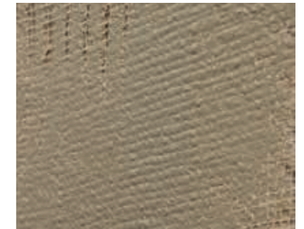
Einlage von maxit Armierungsgewebe Jute in den maxit ip 339 zur Reduzie- rung möglicher Risse.
