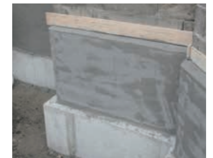
Ebene Fläche mit maxit san Stop und Ausbildung der Hohlkehle.
