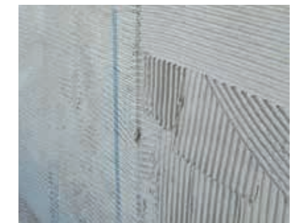
Auftrag der Armierungslage mit maxit multi 292/maxit multi 285/maxit multi 300.
