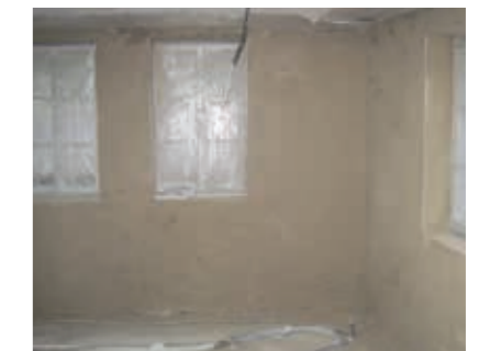
Dämmputz maxit ip 76 therm in einer Auftragsdicke von max. 80 mm in zwei Putzlagen.
