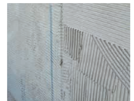
Auftrag der Armierungslage mit maxit multi 292/maxit multi 300.
