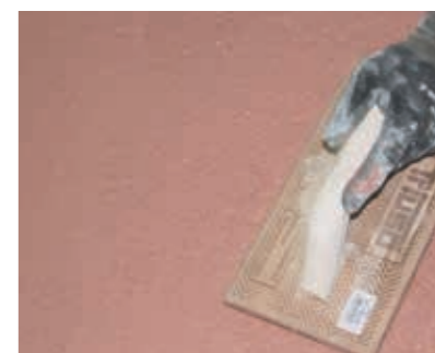
Strukturgebung durch Holzbrett. Kreisförmige Bewegung des Brettes, um eine bewegte Struktur zu erreichen.
