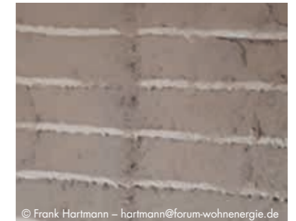
Ausgleichslage und Putzlage zur Über- deckung der Heizungsrohre mit maxit ip 338/ maxit ip 339.
