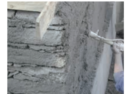
Volldeckender Spritzbewurf mit maxit san Vorspritz und Auftrag eines Sperrputzes mit maxit san Stop.
