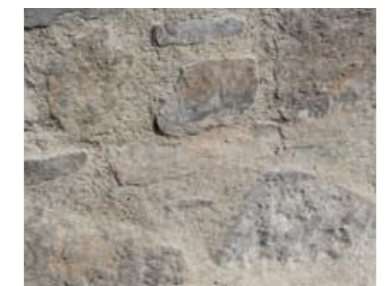
Nachreinigung der Steinoberfläche durch Sandstrahlen für eine raue Fugenoberfläche.
