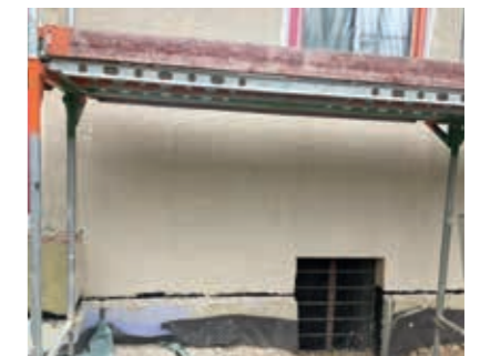
Unterputz mit maxit san Solo, Oberfläche mit maxit eco 70 aufgezehnt.
