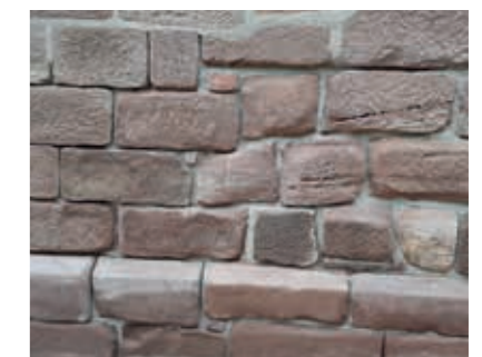
Fugung mit maxit san Grund Porengrundputz. Bei salzbelasteten Fugen unbedingt zweilagig verfugen.
