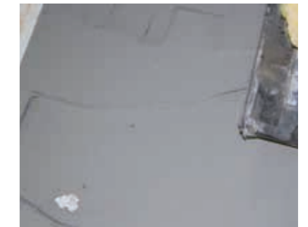
Auftrag der Putzschicht in gewünschter Putzdicke.
