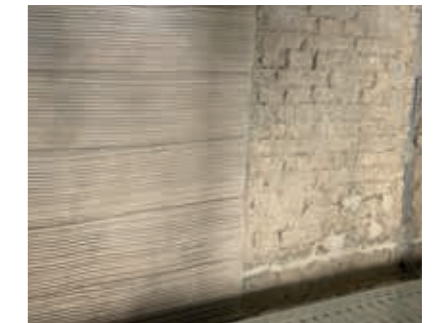
Putzgrundvorbereitung: maxit san Vorspritz oder Kammspachtelung für maxit ip 76 therm, maxit eco 70 für maxit eco 71.
