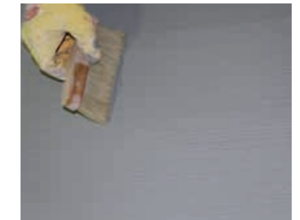
Struktur mit einem Besen erstellen.
