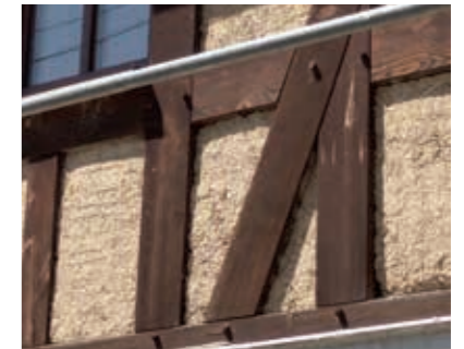
Freigelegte Gefache. Untergrundvorbereitung abhängig von den zu erwartenden Putzdicken und vorliegendem Gefachbaustoff.
