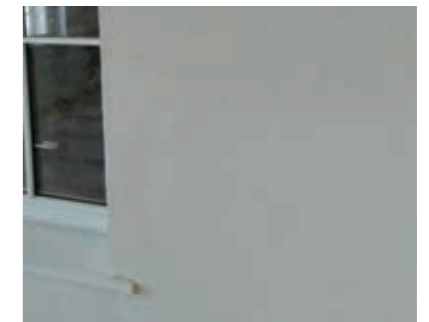
Kalkputz als Deckputz gefilzt.
