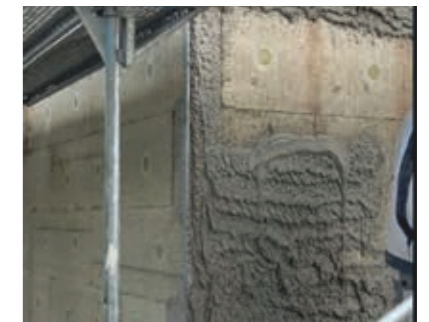
Aufspritzen der ersten Putzschicht maxit ip 78 therm, z. B. auf maxit MW-Fassadendämmplatte speedy II.
