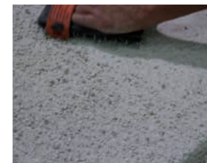
Oberfläche mit einem Kratzigel aufrauen.
