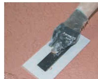
Vergleichmäßigung der Struktur durch ein Kunststoffreibebrett.
