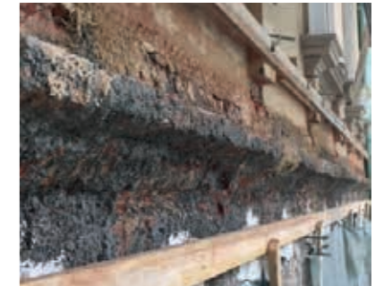
Untergrundvorbehandlung mit maxit san Vorspritz, Lattung zur Führung und Stabilität des Zuges mit der Schablone.
