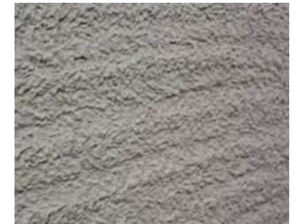
Putzauftrag maxit ip 360 in einer Auftragsdicke von 10 – 15 mm.
