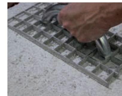
Angetrocknetes Material mit dem Gitterrabortt begradigen.
