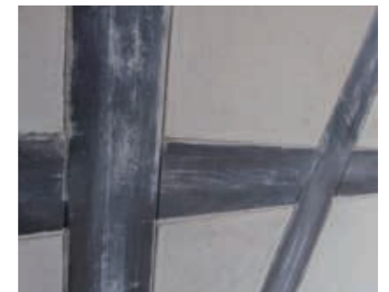
Auftrag eines Kalk- bzw. Kalk-Zementputzes in gleichmäßiger Putzdicke. Keine Verwendung von stark hydrophoben Putzen.
