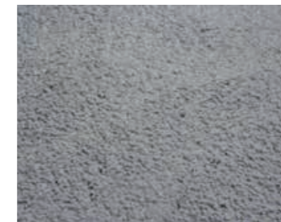
Frisch aufgezogener Kratzputz. Beachten: Das Material ist in 3-facher Kornstärke aufzuziehen.
