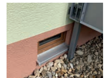
Fachgerecht fertiggestellter Sockel.
