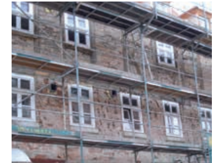
Fachwerk komplett freigelegt, Untergrund gereinigt.
