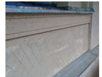
Kalkputz maxit ip 390 mit rabottierter Oberfläche.
