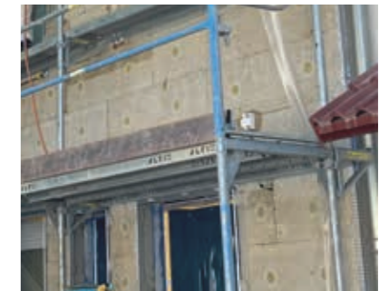
Verklebung der EPS-/MW-Dämmplatten nach Zulassung mit Verdübelung.
