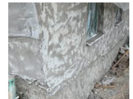
Putzauftrag mit maxit san Vario in einer Gesamtauftragsdicke von 30 mm.
