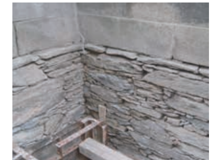
Gereinigter Untergrund, Fugen freigelegt.
