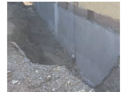
Ausgleich der Unebenheiten mit maxit san Stop.
