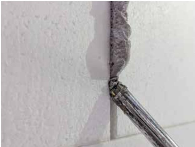
Bild 5: Beispielhafte Verfüllung einer Dämmplattenfuge
