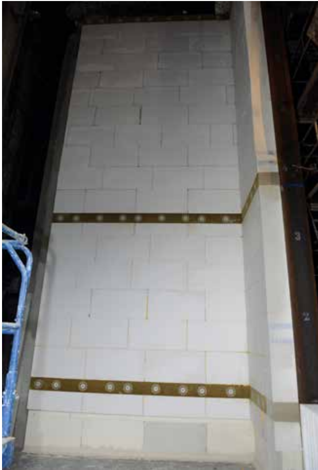
Bild 21: Versuchsaufbau Dämmbereich mit Brandriegeln
