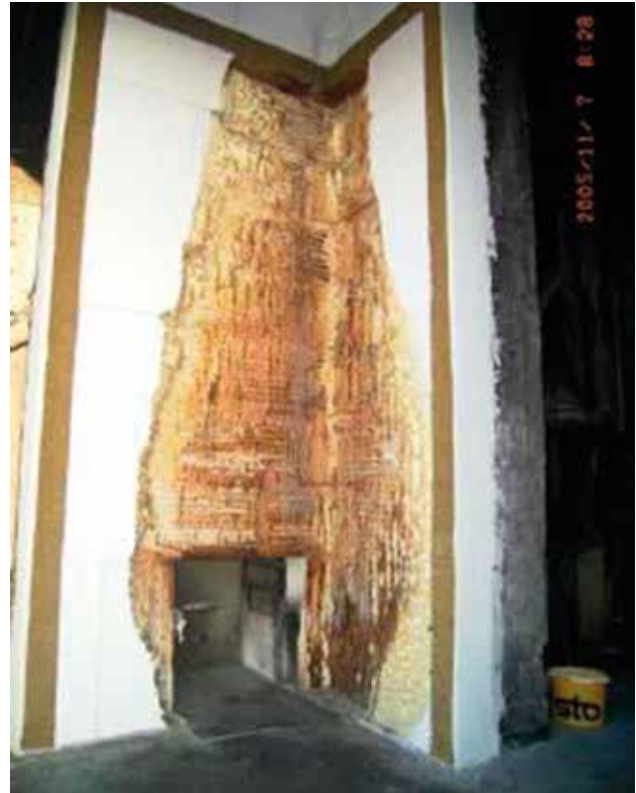
Bild 18: WDV mit EPS-Dämmstoff nach Validierungsversuch und oben angeordnetem Brandriegel aus MW
