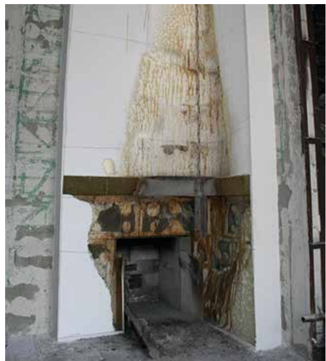
Bild 11: Dämmung nach der Brandprüfung (Putz entfernt)
