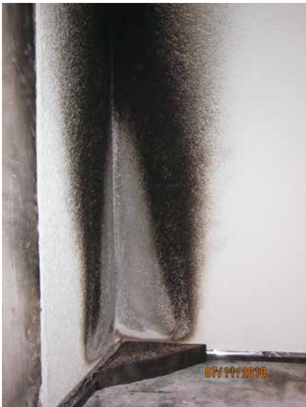
Bild 9: SBI-Prüfkörper (WDVS) nach der Brandprüfung
