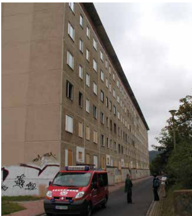
Bild 12: Versuchsgebäude im Ausgangszustand
