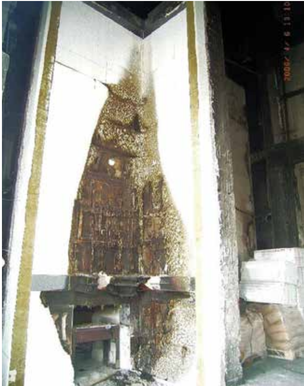
Bild 17: WDV mit EPS-Dämmstoff nach Validierungsversuch und unten angeordnetem Brandriegel aus PU
