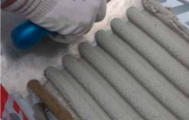
Bild 3: Verklebung eines Brandriegels – Vollflächige Verklebung, hier erreicht durch „Aufzählen“ auf den Untergrund und auf die Brandriegelrückseite (Floating-Buttering) sowie durch die dem Untergrund angepasste Zahnung.
