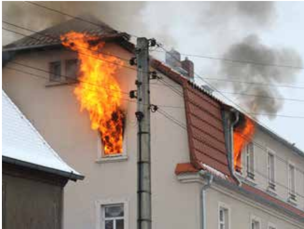
Bild 2: Flammenaustritt aus einem Raum vor die nicht gedämmte Fassade nach dessen Durchzündung (flash-over)
