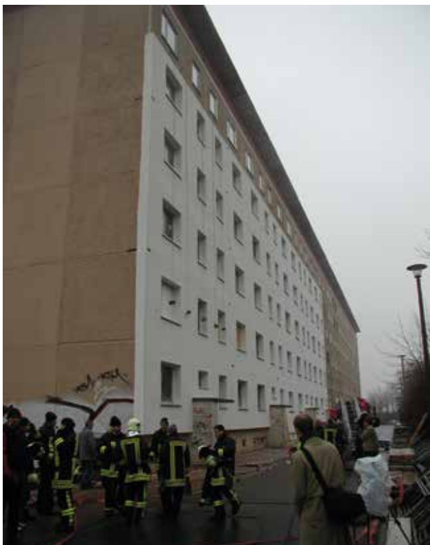
Bild 15: Versuchsgebäude mit WDVS
