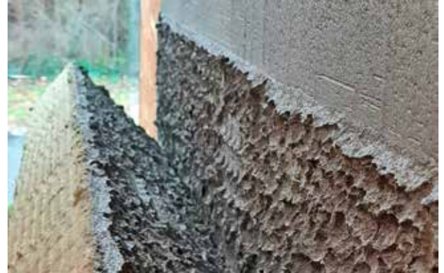
Bild 4: Verklebungskontrolle – Der Klebeflächenanteil muss kontrolliert werden. Hier wurde eine ausreichende und annähernd vollflächige Verklebung erreicht.
