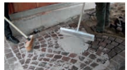
8. Mit Gummischieber oder Besen in die Fugen einbringen und verdichten.
