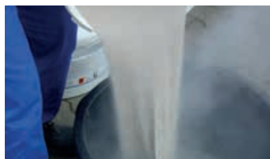
3. Sand in geeigneten Mischbehälter füllen.
