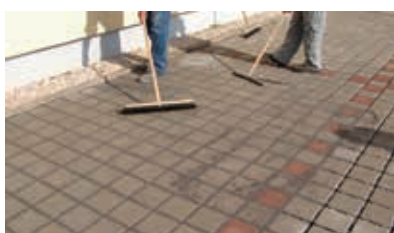
11. Keine Reste des Pflastermörtels auf den Steinköpfen lassen.
