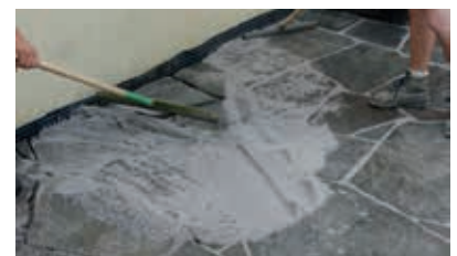
7. Das fertige Mischgut aufbringen und verteilen.
