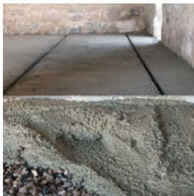
Dünnestrich auf Blähtonfüllung
