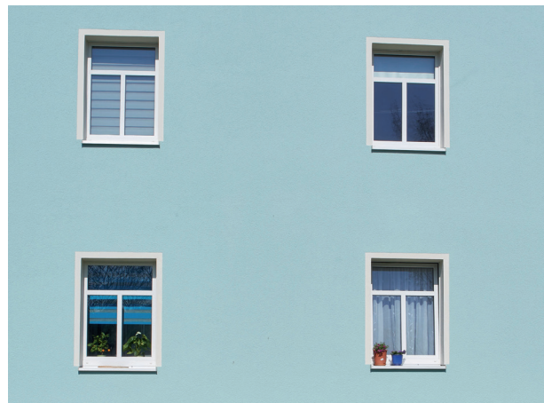
Dank der Außenwandbeschichtung maxit solaren sind die Fassaden dauerhaft vor dem erneuten Auftreten von Dübelabzeichnungen geschützt.
