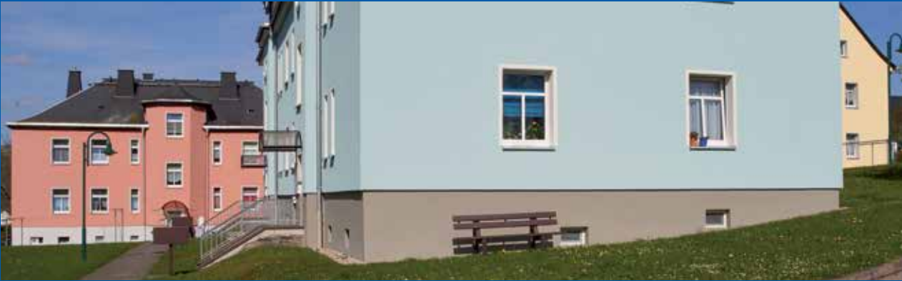
Der Anstrich mit maxit solaren verleiht den Hausfassaden der Wohnanlage Raschau eine ganz neue Farbfrische. Drei unterschiedliche Pastelltöne bilden harmonische Kontraste, abgestimmt auf das ursprüngliche Farbschema.
