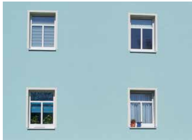
Dank der Außenwandbeschichtung maxit solaren sind die Fassaden dauerhaft vor dem erneuten Auftreten von Dübelabzeichnungen geschützt.
