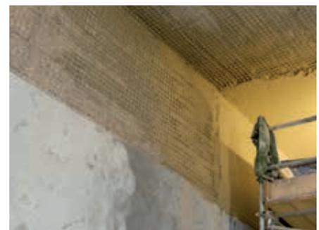
Ergänzend zur Haftbrücke: Vor Aufspritzen des Brandschutzputzes wurde in Lüdenscheid – entsprechend der geltenden Richtlinie – eine 50 x 50 mm Edelstahlbewehrung als Putzträger integriert.
