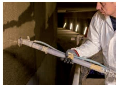
Im Spritzputzverfahren: Bis zu 40 Millimeter „maxit ip 160“-Brandschutzputz wurden bei der Sanierung des Tunnels aufgetragen.
