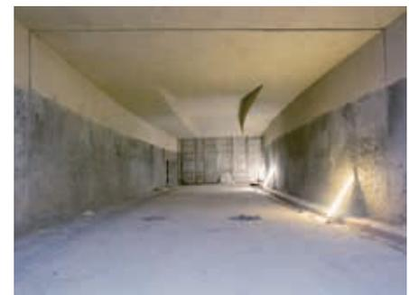
Tunneldecke sowie der erste Meter Wand abgehend von der Decke: Der Rathaustunnel in Lüdenscheid musste auf einer Länge von rund 350 Metern brandschutztechnisch entsprechend den heutigen Anforderungen ertüchtigt werden.
