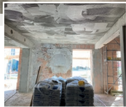
Untergrundvorbereitung mit Haftbrücke maxit multi 280
