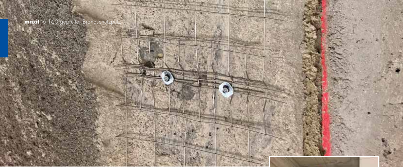
maxit ip 160 Brandschutzputz – Untergrundvorbereitung mithilfe von Putzträgern
