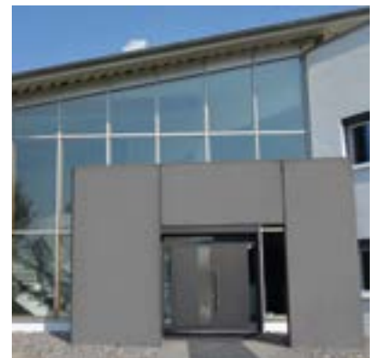
Das Schulungszentrum in Niederwinkling
