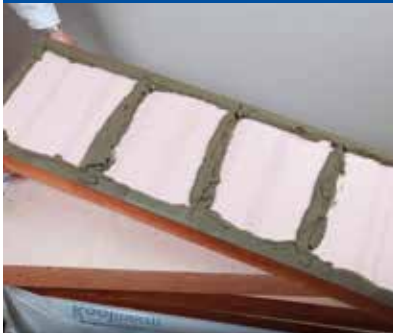
Kleberauftrag im Rand-Streifen-Verfahren
