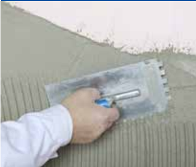
Auftragen des Armierungsmörtels
