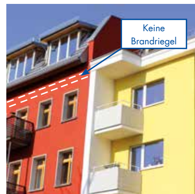
Eine Dämmung mit Resolhartschaumplatten macht Brandriegel unnötig.
