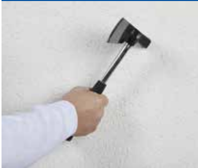
Hammerprüfung auf Hohlstellen
