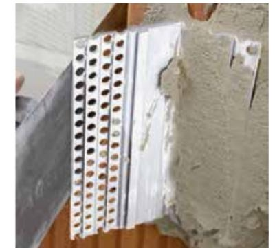
Bei der Laibungsausbildung mit Mineralwolle-Laibungsdämmplatten erfolgt die Ausführung des Anschlussbereiches Fensterblech z. B. mit Fugendichtband (WDVS-Detail). Der Anschluss an den Fensterrahmen kann dann mit den für den Anwendungsbereich ausgelegten **maxit** Anputzleisten erfolgen.
