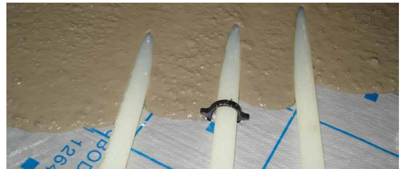
Abb. 2: Optimale Wärmeübertragung: Fließbestrich über Heizrohr nach einer Stunde Vorlaufzeit bei 45 °C
